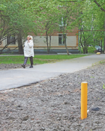
После завершения работ двор вновь зазеленеет.
