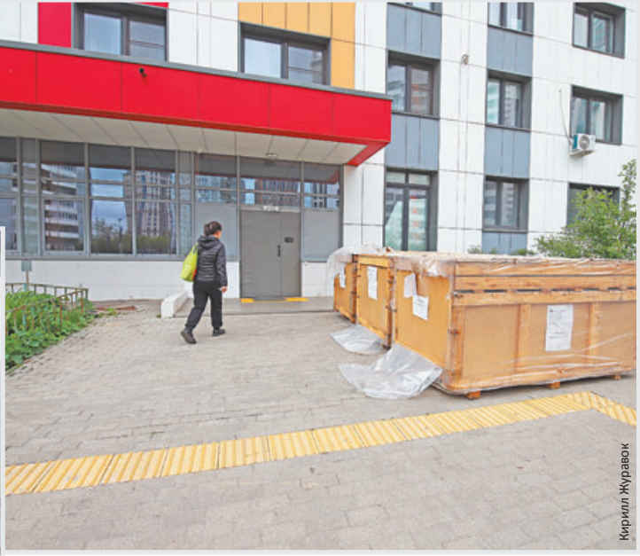
Часть лифтов в доме уже работает, монтаж остальных проводится по плану.
