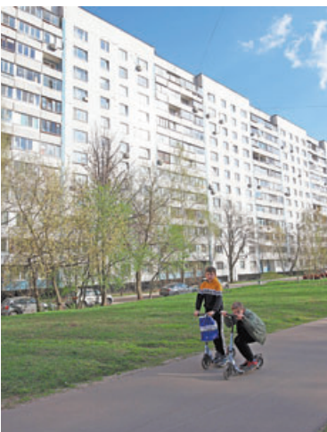
Жители дома подтвердили, что ремонтные работы завершены.
